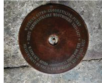
Foto 3. Struve astro-geodeetiline punkt Tartu Tähetorni põrandal (Foto Karin Kollo, 2008)
